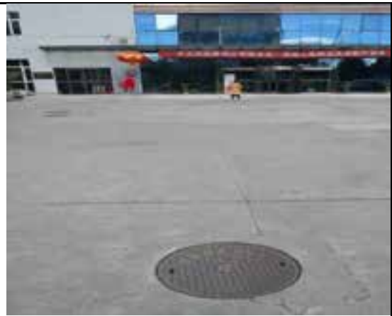
厂区内污水管道
